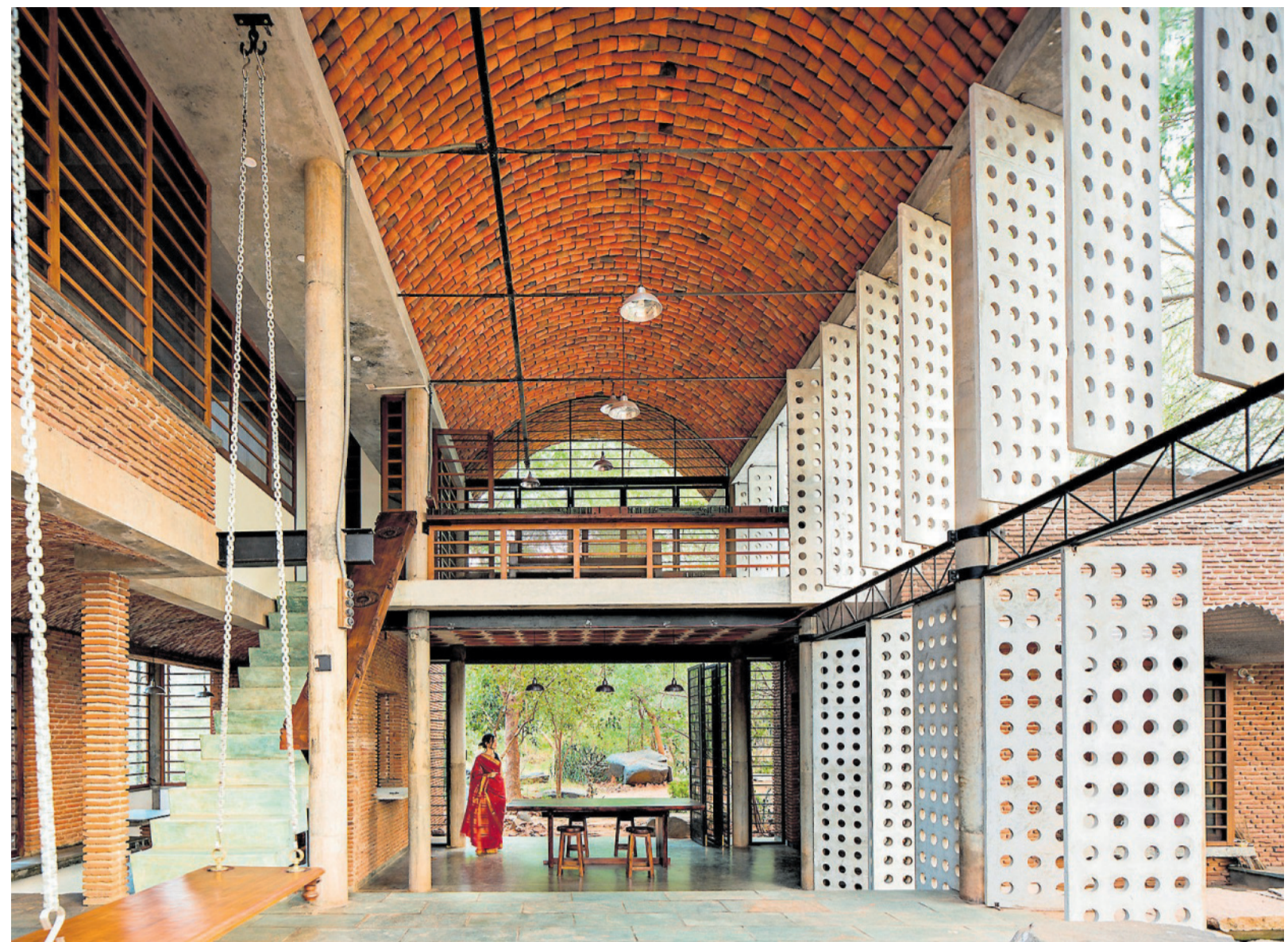
Schönheit muss nicht teuer sein: In ihrem eigenen „Wall House“ in der indischen Stadt-Utopie Auroville experimentierte die Architektin Anupama Kundoo mit preiswerten traditionellen und neuen Baumaterialien: Ziegel, Holz, Beton. Bild: javiercallejas.com
